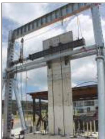
Figura 44. Muro W1 construido a escala real.
