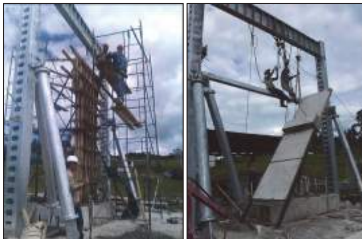
Figura 43. Procedimiento constructivo de los muros EIA. Muro W1 (izquierda). Muros W2 y W3 (derecha)
